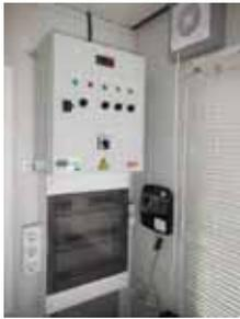
Foto 72. Sistema de control de las válvulas situadas en el sistema de tuberías que traen agua del lago hacia el laboratorio o hacia las piscinas exteriores. Sistema de programación de riego. 2/1/14.
