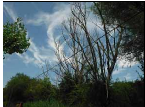
Arbres amb risc de caiguda a la riera Marquès
