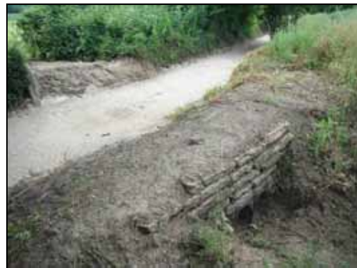
Reparació d'un dels punts crítics del camí
