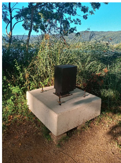
Instal·lació d'infraestructura temporal al voltant de l'Estany
