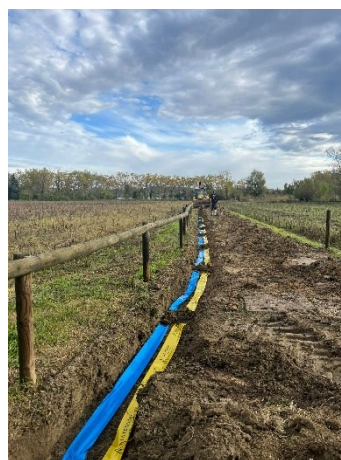
Instal·lació de la xarxa d'aigua i elèctrica del sistema de captació d'aigua d'Estany
