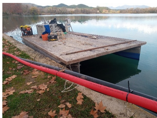
Instal·lació de la xarxa d'aigua i elèctrica del sistema de captació d'aigua d'Estany
