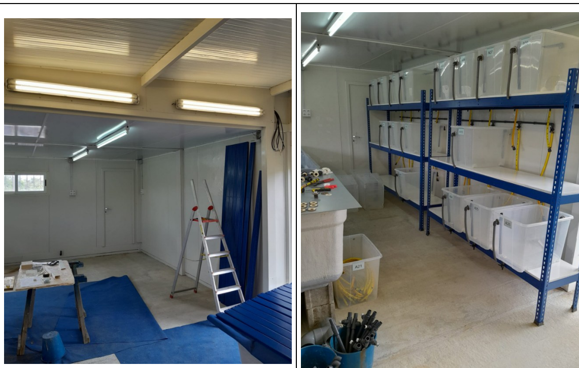
Treballs de millora a l'espai interior del laboratori
