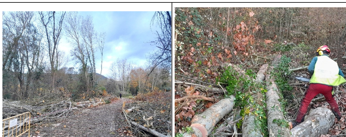
Treballs de millora estructural del bosc
