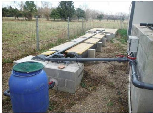
Foto 66. Nuevos canales para juveniles de náyade de 2013. Sistema de control de nivel del agua y desagüe. 11/3/13.
