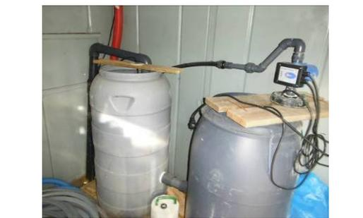
Foto 70. Sistema de electro-válvulas para el control del sistema de agua procedente de la bomba del lago. Compresor de aire que alimenta el laboratorio. 16/3/12.
