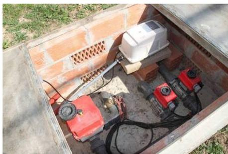
Foto 71. Depósitos donde se almacena agua del lago y sistema de bombeo a presión hacia dentro del laboratorio de náyades. 4/1/14.
