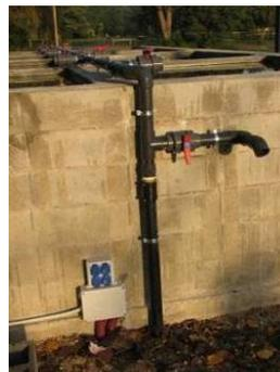
Foto 52. Sistema de entrada de agua de las piscinas exteriores del laboratorio. 16/1/10.
