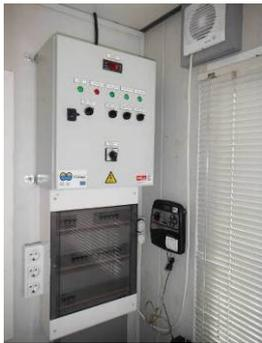
Foto 72. Sistema de control de las válvulas situadas en el sistema de tuberías que traen agua del lago hacia el laboratorio o hacia las piscinas exteriores. Sistema de programación de riego. 2/1/14.
