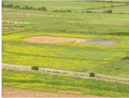
Figura 16. Construcció d'una bassa didàctica a Santa Eularieta.
