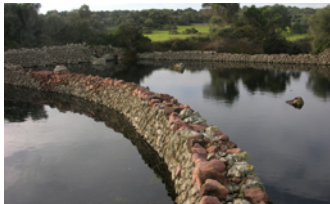
Figura 3. Parets seques per dividir la Bassa des Mal Lloc.
