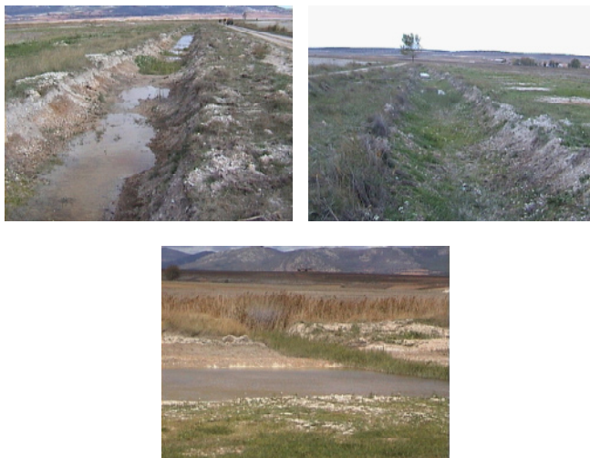
Figuras 16, 17 y 18. Drenaje y balsa del Prado de Las Cuerlas y humedal de la Reguera tras los trabajos de restauración.
