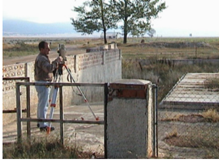
Figura 11. Trabajos de recuperación de balsa.
