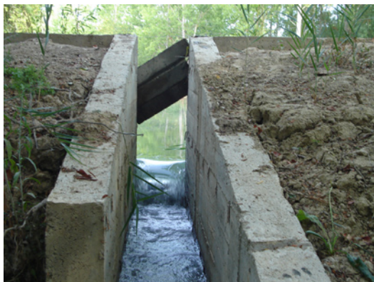
Figura 10. Vista d'un bagant de sortida amb les plaques que actuen com a comporta.
