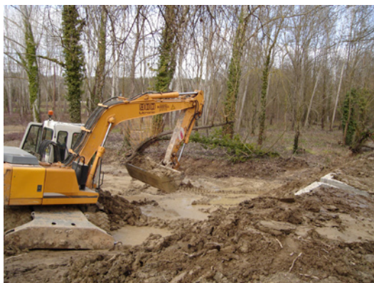
Figura 9. Màquina en el moment de l'excavació.
