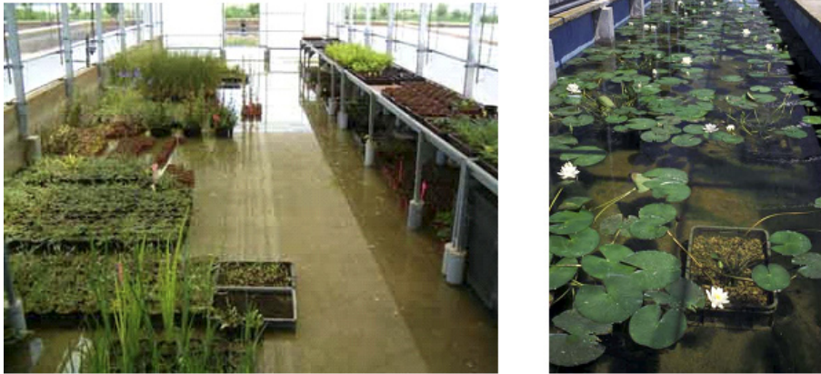
Figura 2 y 3. Instalaciones C.I.P. de El Palmar. Invernadero y balsa de macrófitos.
