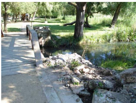
Derribo del puente sobre la acequia del Vilar
