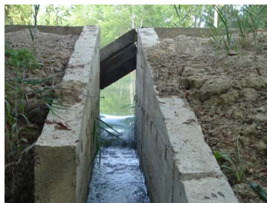
Vista de la compuerta de salida con las placas que actúan como estructura de regulación del
