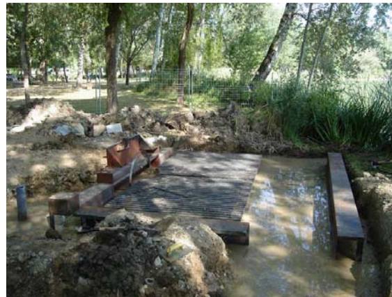
La nueva fuente en el momento de la instalación
