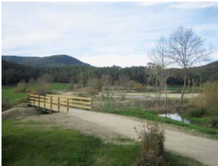
Vista del puente y el camino de acceso al mirador de la laguna de Margarit.
