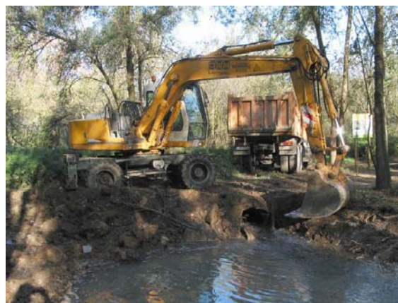
Maquina retirando tubos de hormigón en el arroyo de Lió
