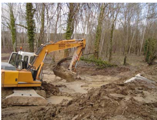
Máquina en el momento de la excavación (laguna dels Amaradors)
