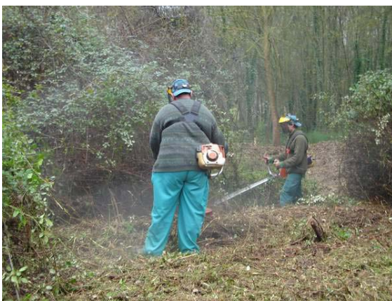
Brigada de mantenimiento cortando la formación de zarzal en el arroyo de Lió
