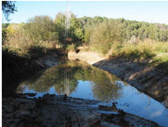
Vista del canal del camino de Goma con poca agua (Noviembre de 2006)
