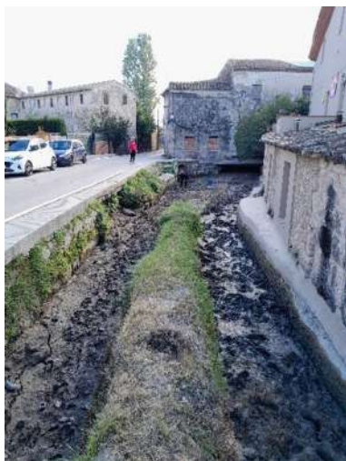
Tram de la bassa del Terme sense aigua
