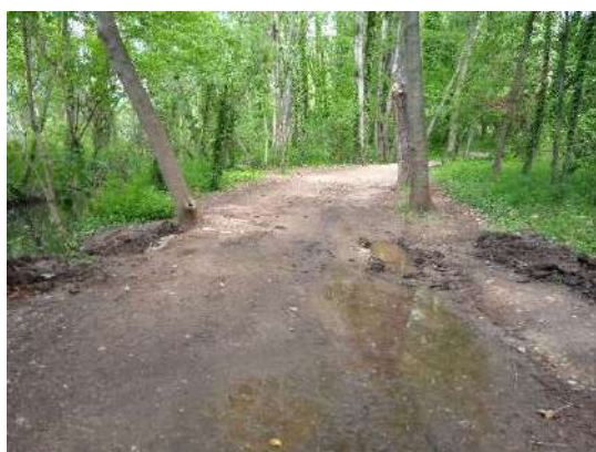
Camí de la caseta abans de l'actuació
