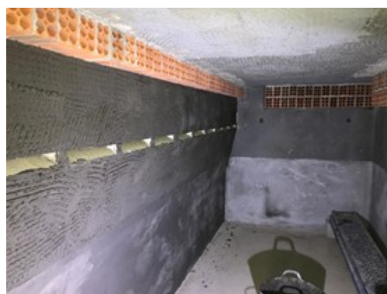
Obres de condicionament de l'interior de la caseta
