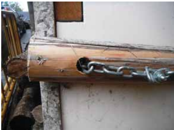
Detall de la part inferior, per on surt la cadena que subjecte els troncs de sobre amb la base.
