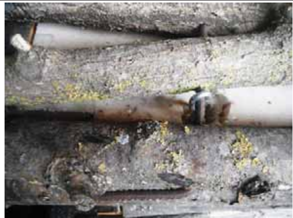
Detall de la cadena agafada a la rea que travessa els troncs.
