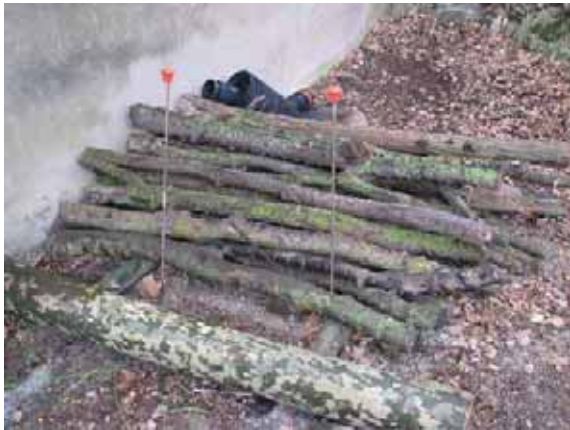
Troncs de freixe i acàcia de diferent diàmetre utilitzats per la part superior de la plataforma.
