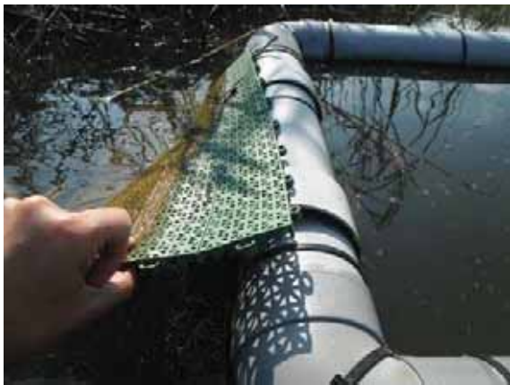
Subjecció de la rampa amb el marc de PVC
