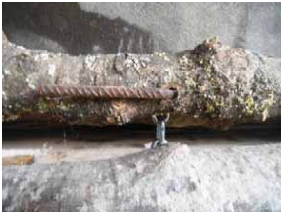
Detall de la rea sobresortint per l'extrem dels troncs. Per sota es veu la cadena que subjectarà els troncs amb la base.
