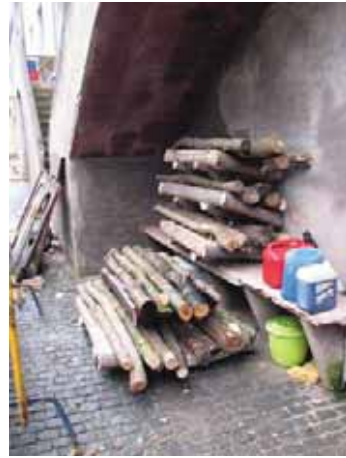
Conjunt de plataformes construïdes per al projecte.
