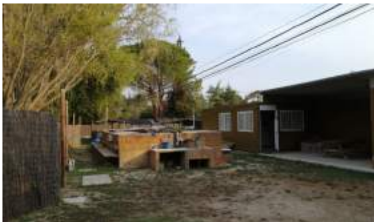
Imatge 5. Canals de formigó
