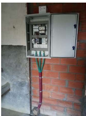
Portada del servei d'electricitat a la caseta del punt control del pastor i instal·lació del quatre elèctric
