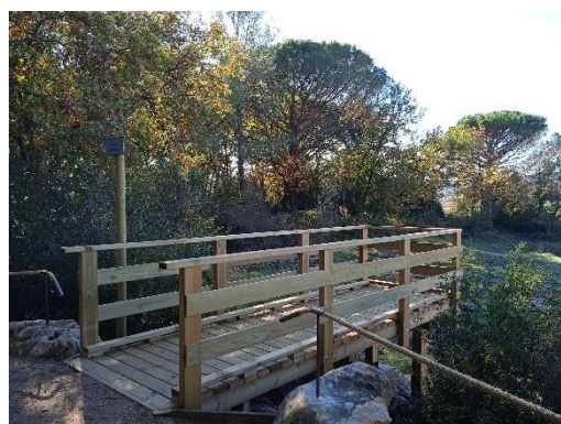
Instal.lació d'una passera mirador
