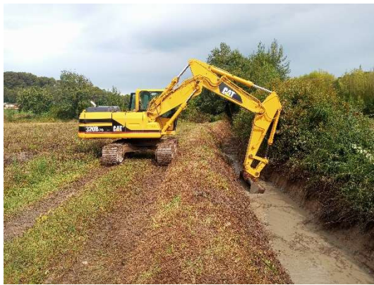
Dragatge i reperfilament de la mota
