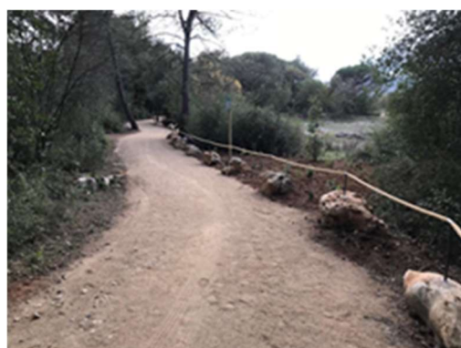
Instal.lació de tanca delimitació
