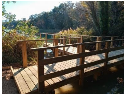
Passera del camí de goma remodelada
