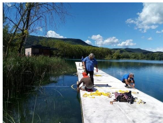
Muntatge instal·lacions esportives
