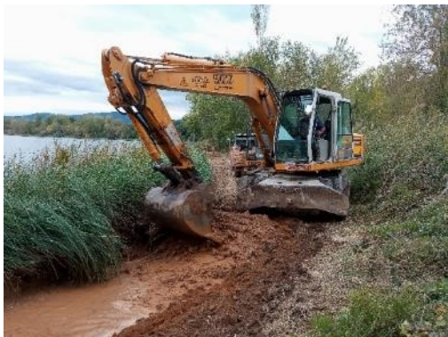
Tram de camí eliminat i rebaix de terra per potenciar els aiguamolls calcaris de la zona
