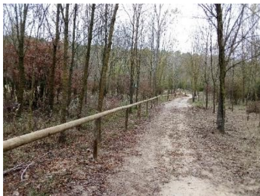
Col.locació de tanca delimitadora
