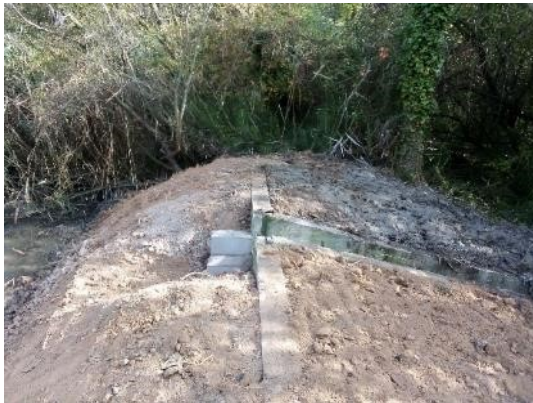
Bagant reparat i mota formada
