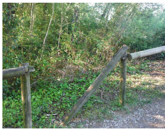
Tanca a reparar
