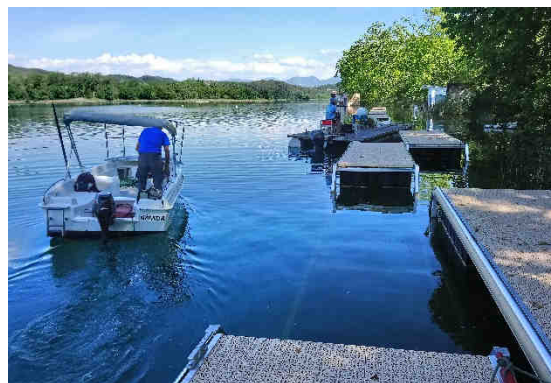
Muntatge instal·lacions esportives
