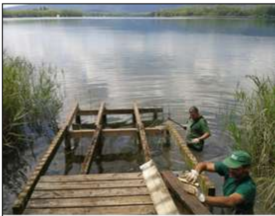
Reparació passera de Lió a l'Estany
