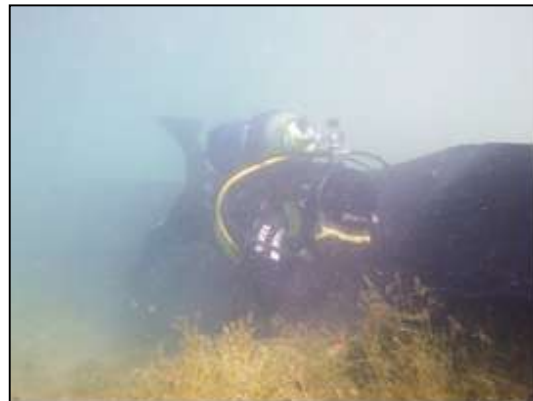
Bussejador instal·lant el plàstic al fons de l'Estany
