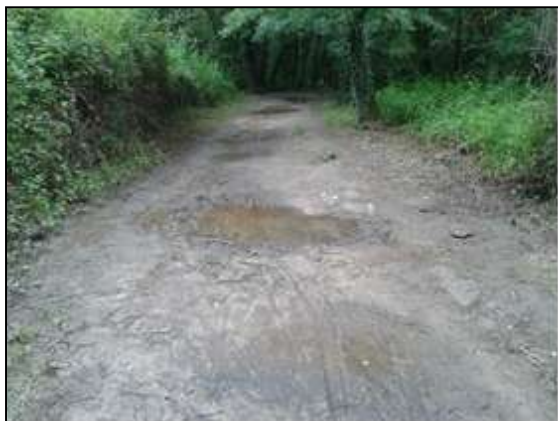
Estat del camí abans de l'actuació
