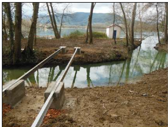
Estructura de ferro
