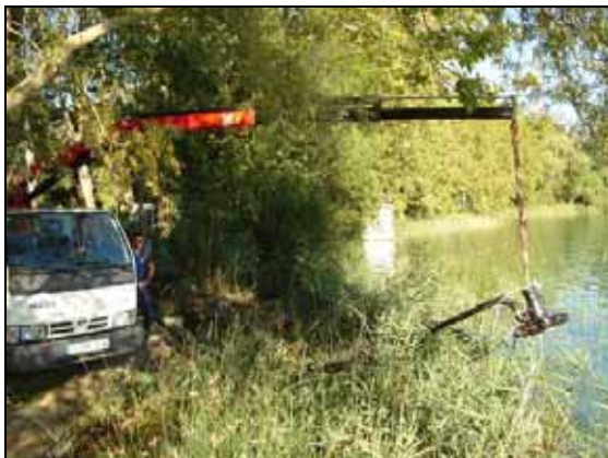
Instal·lació de la bomba de captació de l'aigua de l'Estany
