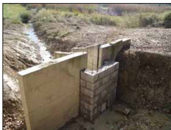
Vista del bagant d'entrada des de la riera una vegada retirada l'escullera i construït el mur de formigó
