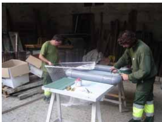
Construcció de les plataformes
