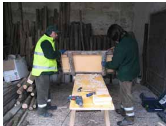
Preparant la base flotant de la plataforma
