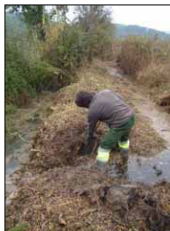
Treballs manuals de la reparació de les filtracions
