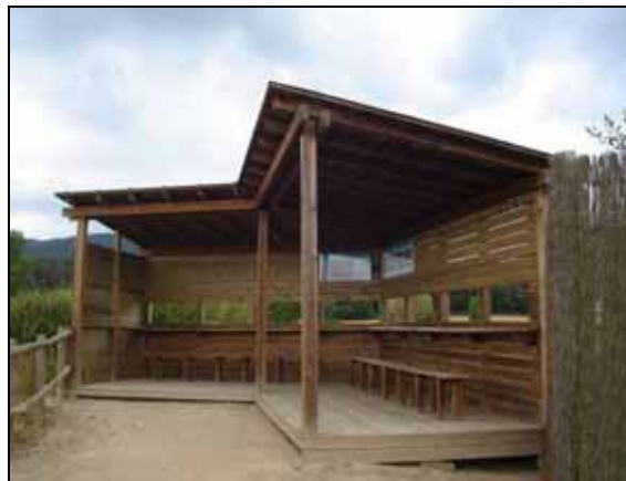
Estat de l'aguait després de reparar-lo
