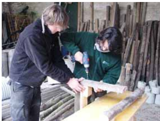
Preparació de la base flotant de les plataformes d'insolació
