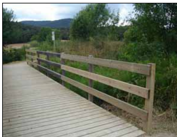
Estat del pont després de la reparació
