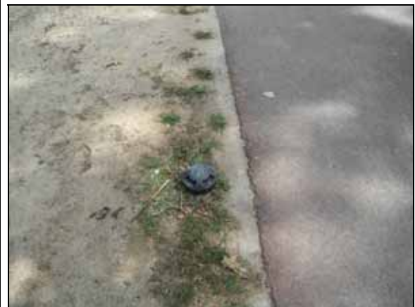
Detall de la il·luminació instal·lada
