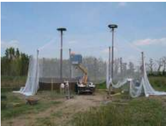
Construcció del nou aviari
